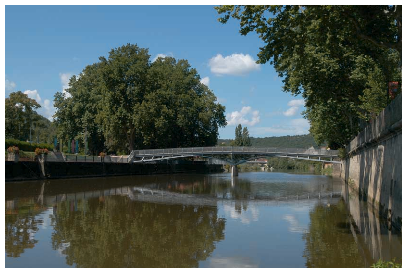
La passerelle en 2004
