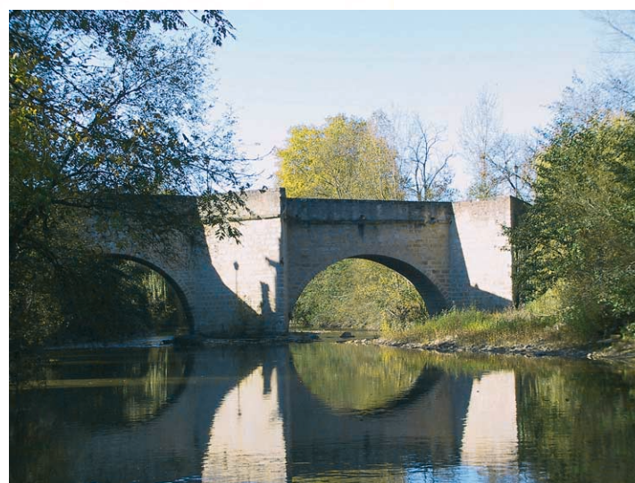
Le pont du Pin en 2004
