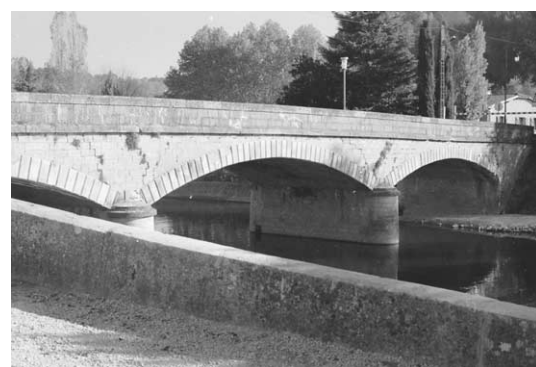
Le pont du Gua avant sa démolition
